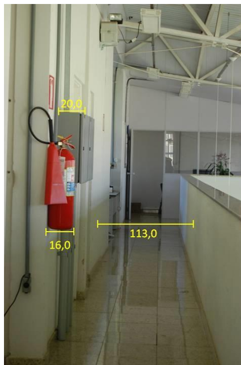
Figura 13 - Medidas do corredor no pavimento superior. Fonte: Arquivo pessoal.
