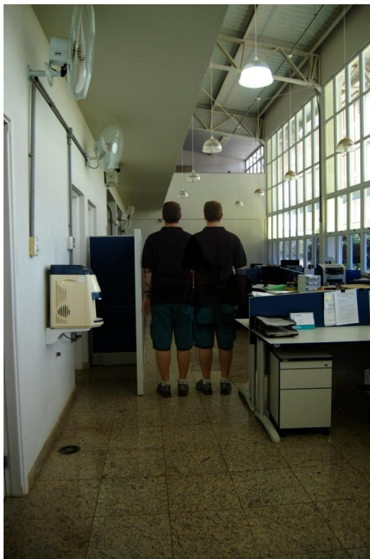
Figura 11 – Sobreposição indicando não conformidade da largura da passagem no pavimento inferior. Fonte: Arquivo pessoal.
