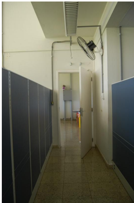
Figura 20 - Porta abrindo contra o fluxo de saída.
