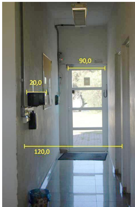
Figura 17 - Corredor que leva à saída da edificação. Fonte: Arquivo pessoal.
