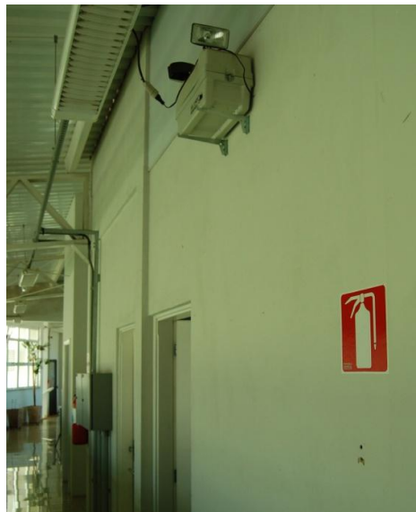
Figura 12 - Bloco autônomo localizado no pavimento superior. Fonte: Arquivo pessoal.
