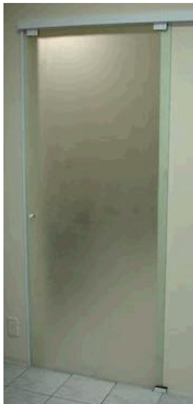
Figura 21 - Porta fosca, de vidro temperado. Fonte: Arquivo pessoal.
